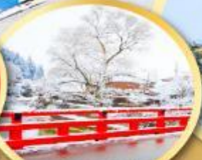
สะพานนากะบาชิ
